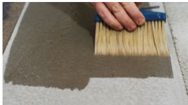
BETON emilimin kontrolü
